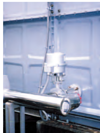
▲受水槽緊急遮断設備
