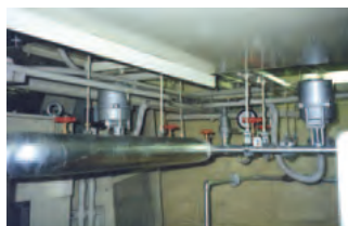
▲受水槽緊急遮断弁
