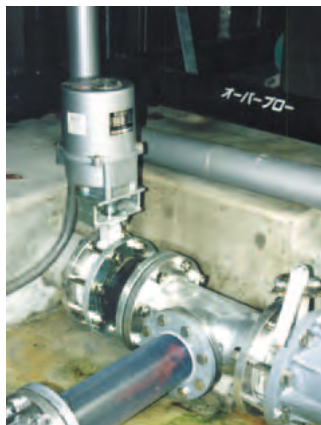
▲受水槽緊急遮断弁
