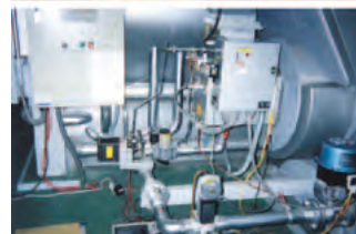
▲ガス吸収式冷温水機
