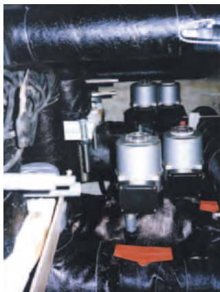
▲大型水族館 濾過給水制御バルブ
